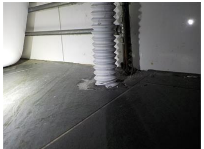
Genomföringar i golvet under kommoden.
